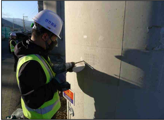
a. 탄산화시험부 천공
