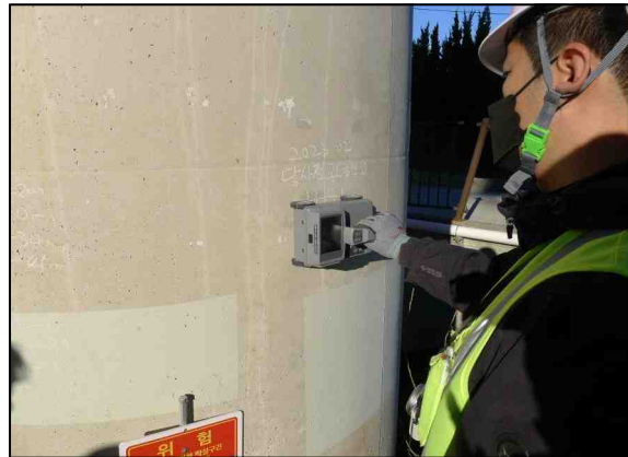
d. 철근탐사 측정
